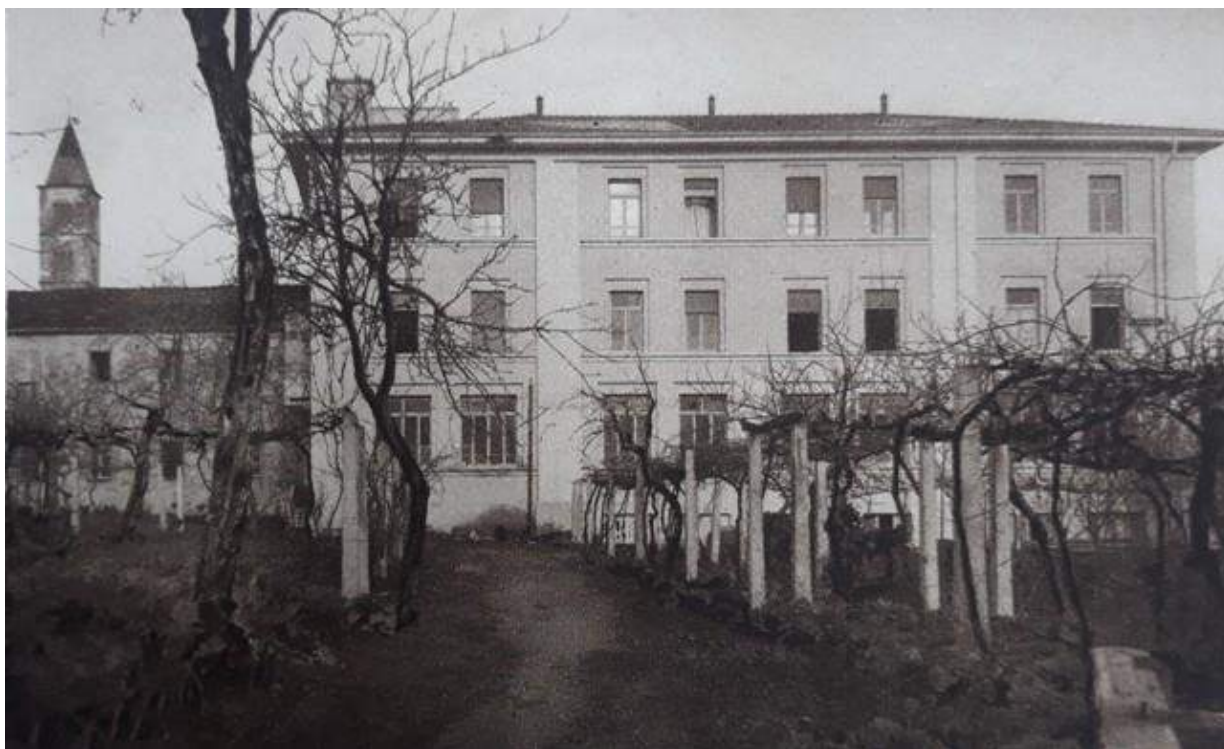
Veduta del retro dell'edificio del Seminario dopo i lavori eseguiti negli anni '50 del Novecento
